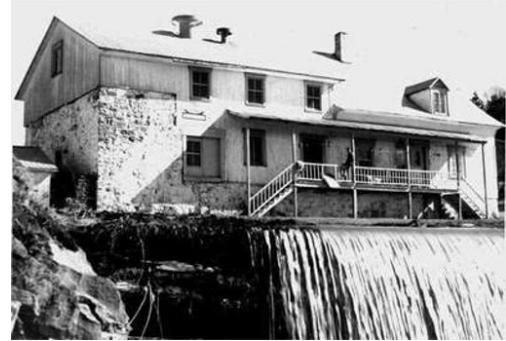
(Photo : Petit moulin des terres à Saint-Aubert)
